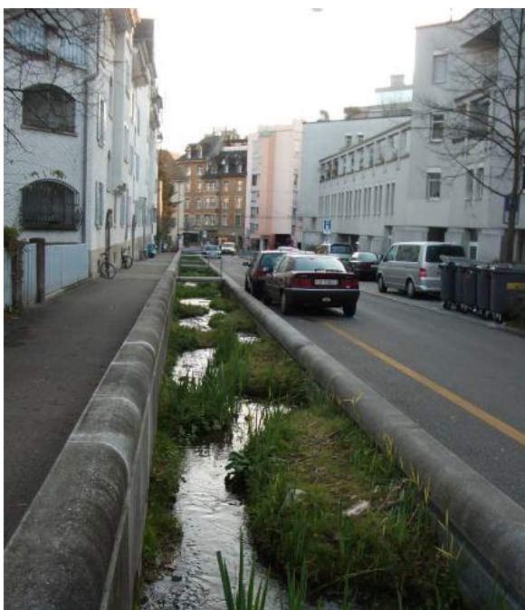
Remise à ciel ouvert d'un cours d'eau (Nebelbach-ZH) - Crédit photo : A. Caille
