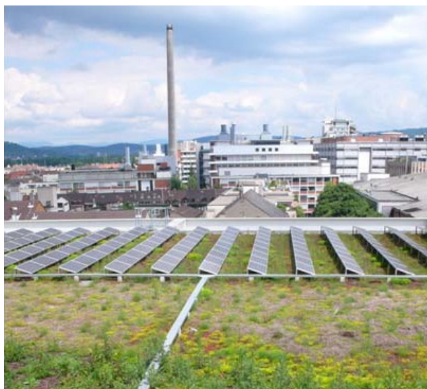
Capteurs solaires associés à une toiture végétalisée (BS) - Crédit photo : N. Baumann
